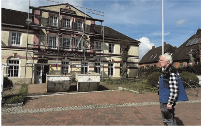
Das Hotel Stadt Kiel am Schönberger Marktplatz ist seit längerer Zeit eingerüstet. Die Innenarbeiten gehen voran, wie der Bauleiter Hans-Jürgen Heide zeigt. Die zehn Zimmer sollen Ende Mai vermietet werden. Im nächsten Schritt folgt der Erneuerungsanstrich der Fassade. Foto: kk
