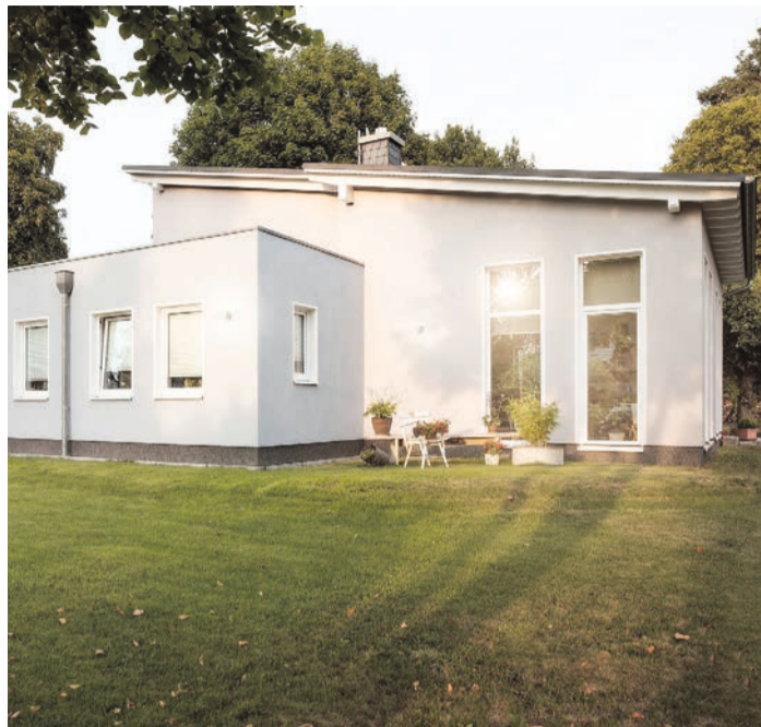
Erst kleiner bauen, später bei Bedarf erweitern: So können Bauherren die Kosten fürs Eigenheim zunächst niedriger halten. Foto: DJD/Bauherren-Schutzbund/Getty Images/Florian Küttler
