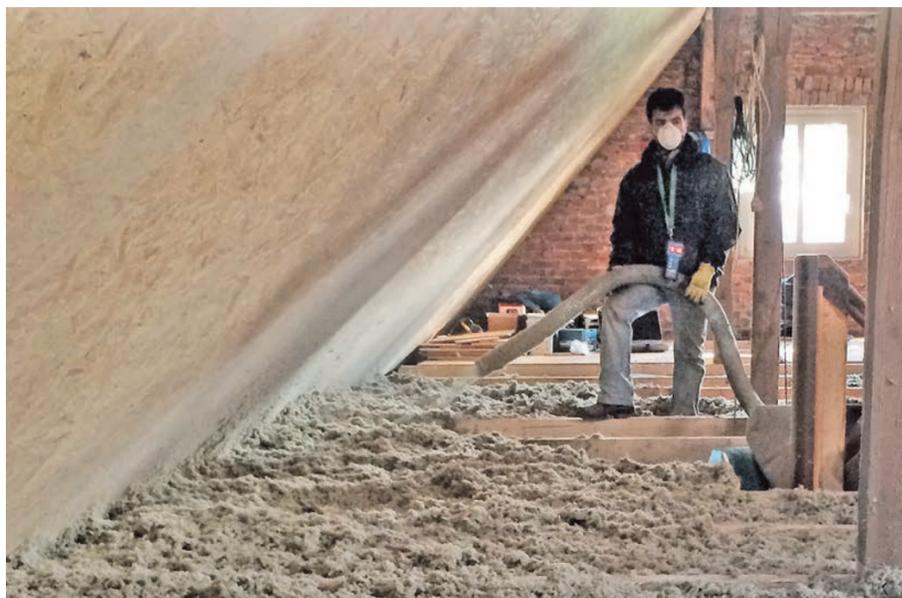
Eine Einblasdämmung mit Steinwolle eignet sich hervorragend für den Einsatz im Dachboden. Foto: DJD/www.ecofibre.de/daemmung
