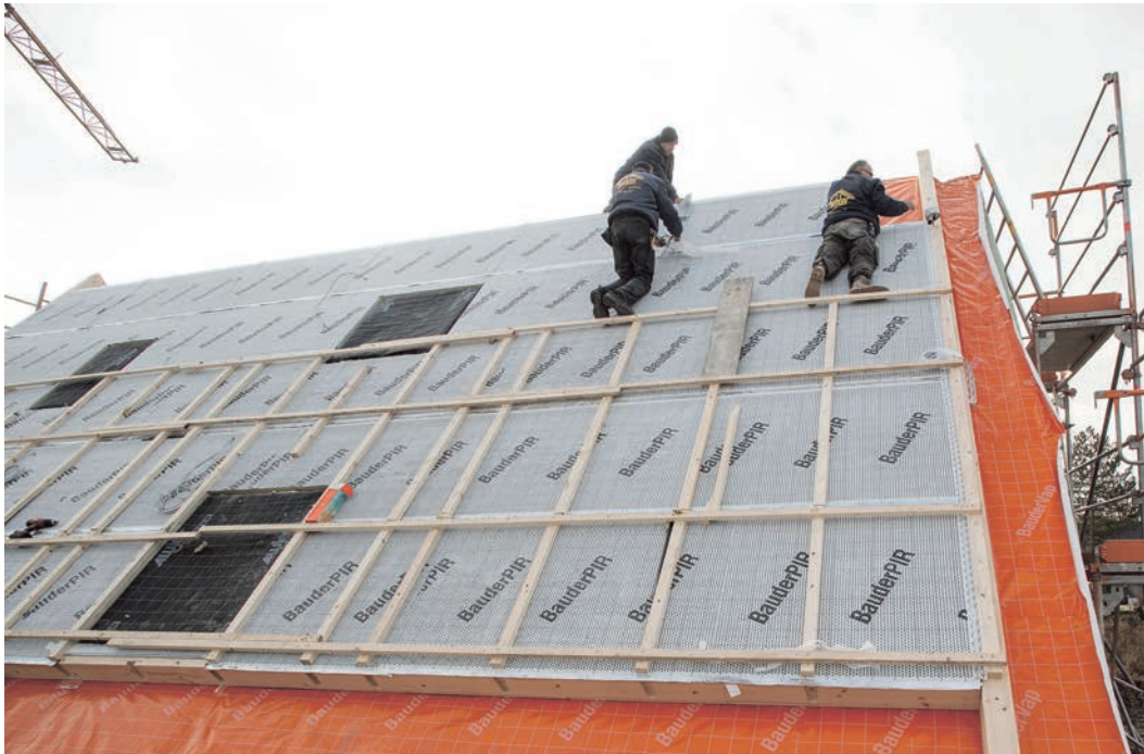
Energie sparen unterm Dach: Eine Aufsparrendämmung lohnt sich auch bei der Altbauomodernisierung. Foto: djd/Paul Bauder/Klaus-Reiner Klebe
